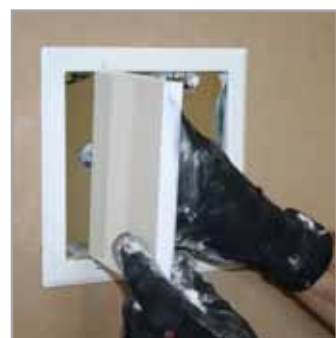
9 Sæt nu lugen tilbage på samme måde som den blev fjernet. Aftør evt. overskydende fugemasse.
