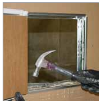
7 Fastgør rammen med de medfølgende beslag. Beslagene placeres lidt skråt mod rammen og slås fast med en hammer. Der placeres lige mange beslag i hver side, alle medleverede beslag skal anvendes.
