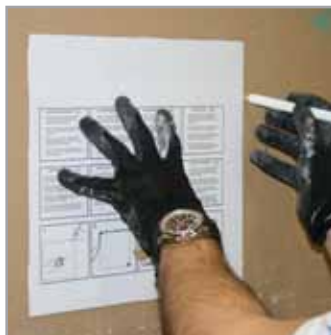
2 Skær skabelonen ud efter perforeringen, og opmærk lugens placering på væggen. Såfremt der ikke opmåles efter skabelon skal hulmål være som lugens nominelle mål, f.eks. 300x300 mm, der må maks. være 3 mm mellem rammen og gipskanten.
