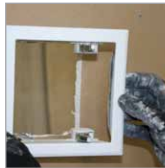
7 Beslut hvordan lugen skal åbne. Ved lemme i større format anbefales det at hængselssiden vender nedad. Tryk rammen fast i hullet.
