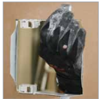
8 Fastgørelsesbeslag bøjes så de fastholder rammen. Enden på beslag bøjes ind mod bagsiden af gipsen, så beslaget ligger dobbelt, hvorefter beslaget bøjes så det klemmer mod gipsen.
