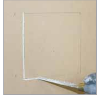
4 Sav efter markeringen. Hvis du har valgt at måle efter rammens indermål, skal du save på udvendig side af stregen.
